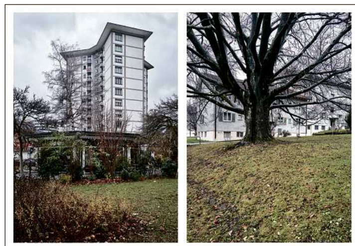
Badenerstrasse (links) und Im Rosswaidli.
